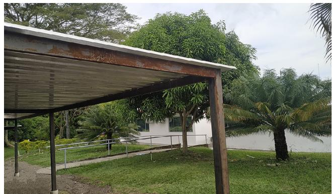
De igual modo, se recomienda un montaje de los paneles solares como se puede ver en la figura 8, con ángulos o perfiles en C en aluminio que van apoyados sobre los perlines de la estructura metálica actual, con un ángulo de inclinación vertical de aproximadamente 14° y con una inclinación horizontal de 2° hacia el norte verdadero; esto, teniendo en cuenta la latitud de Mariquita, Tolima, y la declinación magnética para el planeta tierra.
