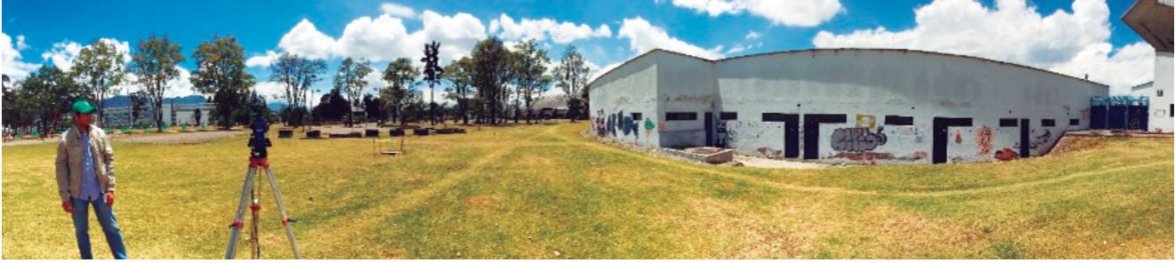
Foto 3. Levantamiento topográfico con estación total de la superficie de estudio. Fuente: autores.
